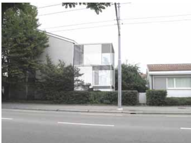
Anbauten bilden eine Abschirmung zur Strasse und schützen einen Teil des Aussenraums vor Lärm.
