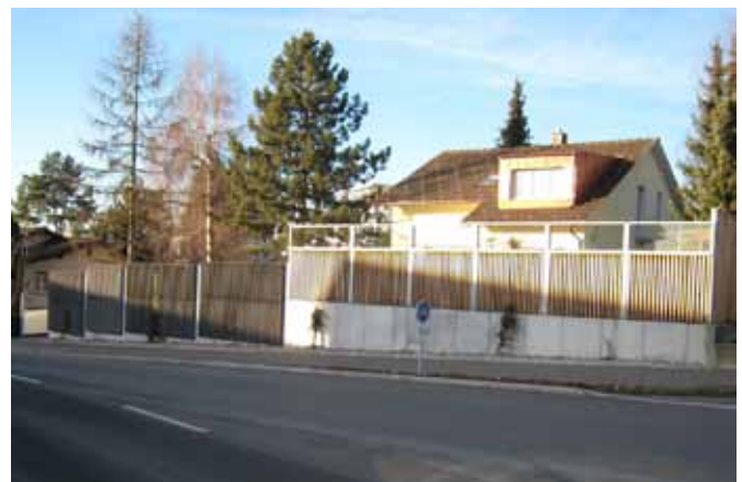
Von einer Mauer aus Steinquadern mit Holzwand über eine Betonmauer mit Holzwand und Glasoberteil gefolgt von einer Elementwand - alles an derselben Strasse.
