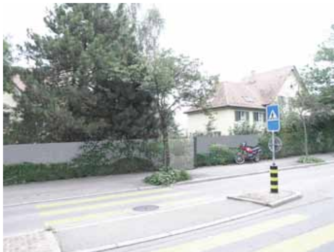
Eine rund 1,5 Meter hohe Lärmschutzwand fügt sich in die Vorgartensituation ein.
