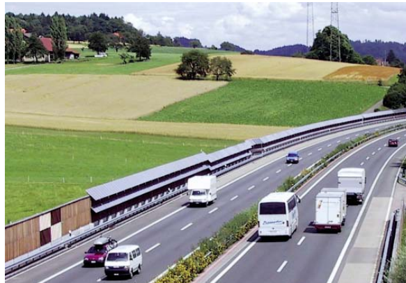
Abbildung 2: PV-Anlage auf einer LSW entlang der A1 bei Safenwil
